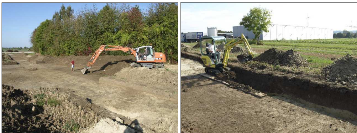
Abb. 4 Links: Flächenerweiterung um Grab 22 im nördlichen Schnitt 3. Rechts: Arbeiten mit dem Minibagger an Graben 4.
