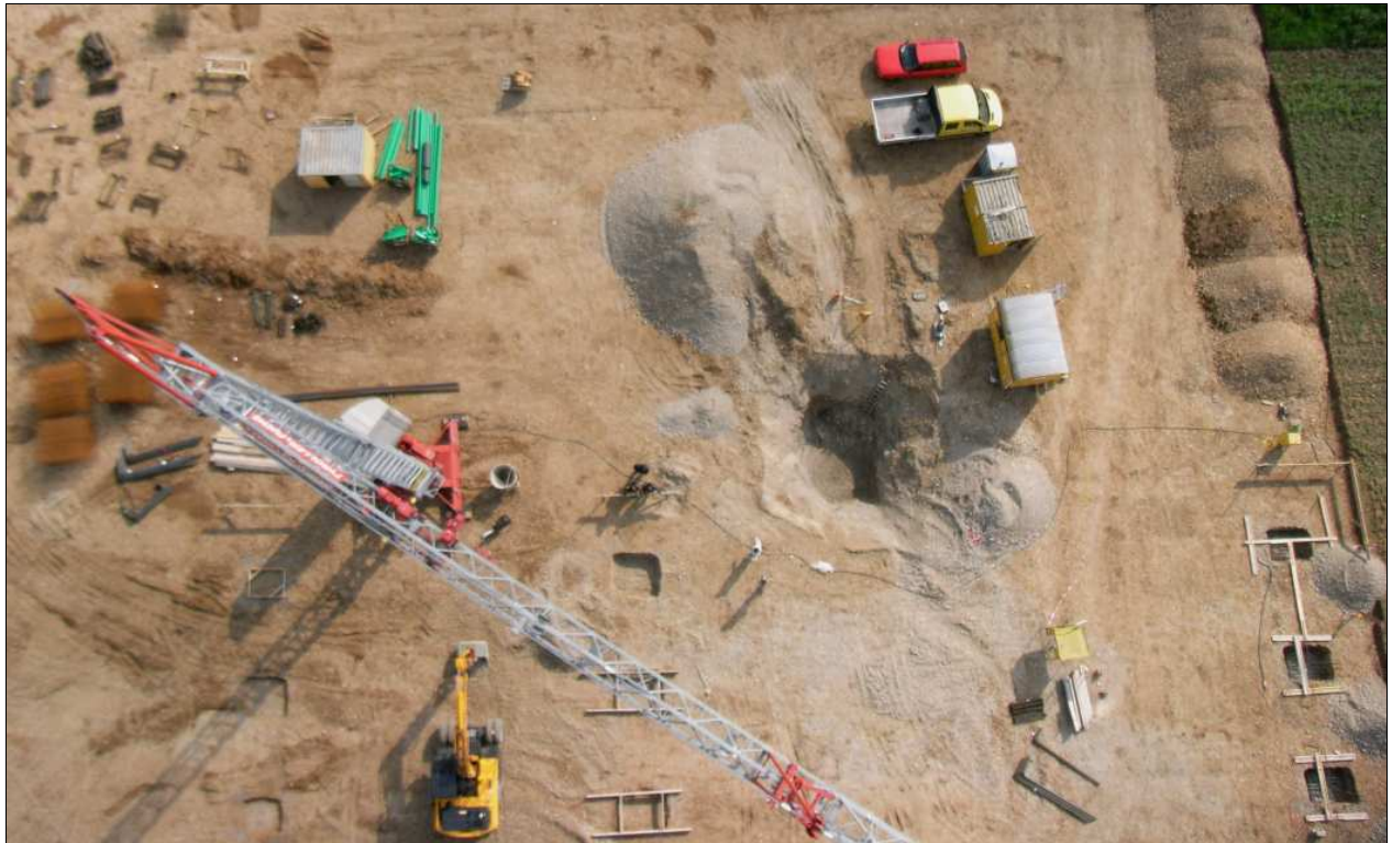
Abb. 25 Während der Bearbeitung des Befundes 7 sind die Fundamentierungsarbeiten für das Fachmarktzentrum bereits im Gange. Luftbild mit dem Hebedrachen.
