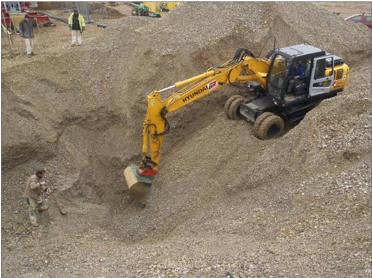
Abb. 28 Arbeiten am Brunnen Befund 7.
