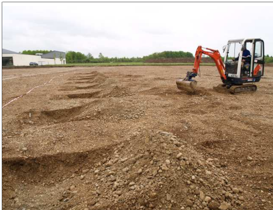
Abb. 7 Anlage der Arbeitsgruben mit dem Minibagger.
