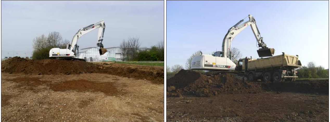
Abb. 6 Links: Feinplanie mit Rotlagelinsen im Vordergrund. Rechts: Abtransport des abgezogenen Materials.
