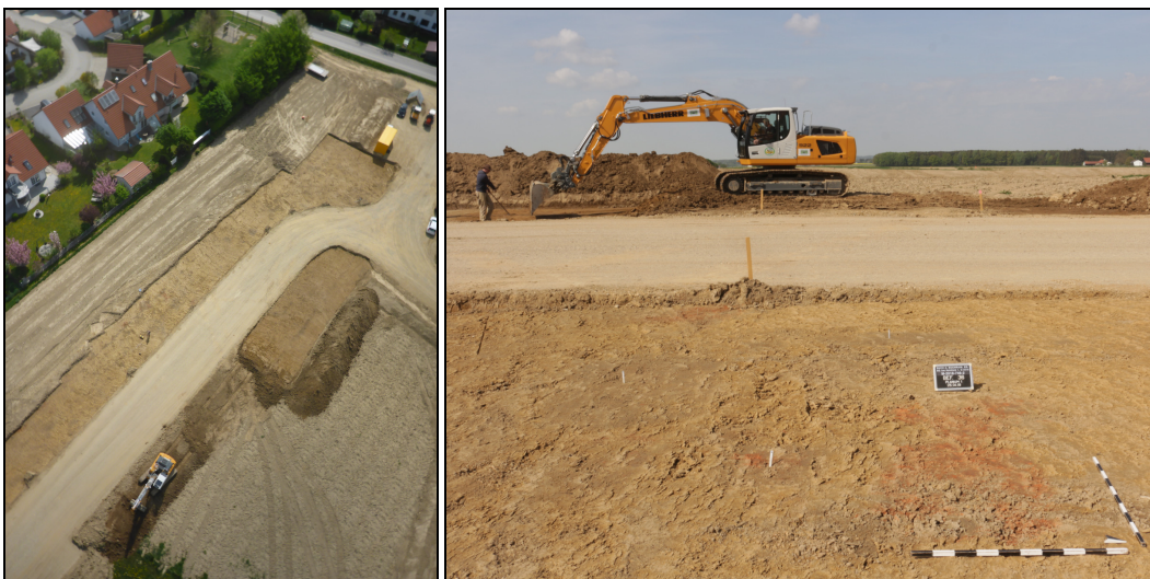
Abb. 1 Links: Flächenöffnungen entlang der aufgekiesten Erschließungsstraße (Luftbild mit dem Hebedrachen). Rechts: Erdbefunde und Verziegelungen im anstehenden Löss.
