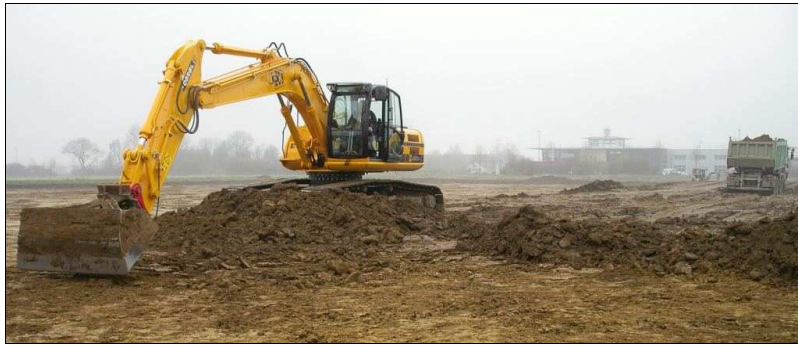
Abb. 5 Der anfallende Mutterboden wird von LKWs abgefahren.
