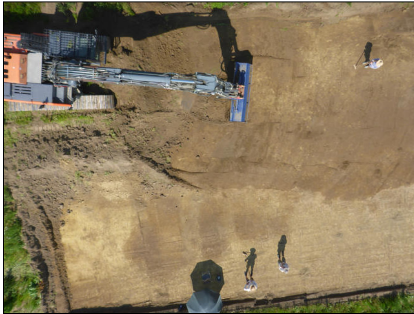
Abb. 3 Oberbodenabtrag im Bereich des 30 m-Streifens auf der Lössterrasse (Luftbild mit dem Hebedrachen).
