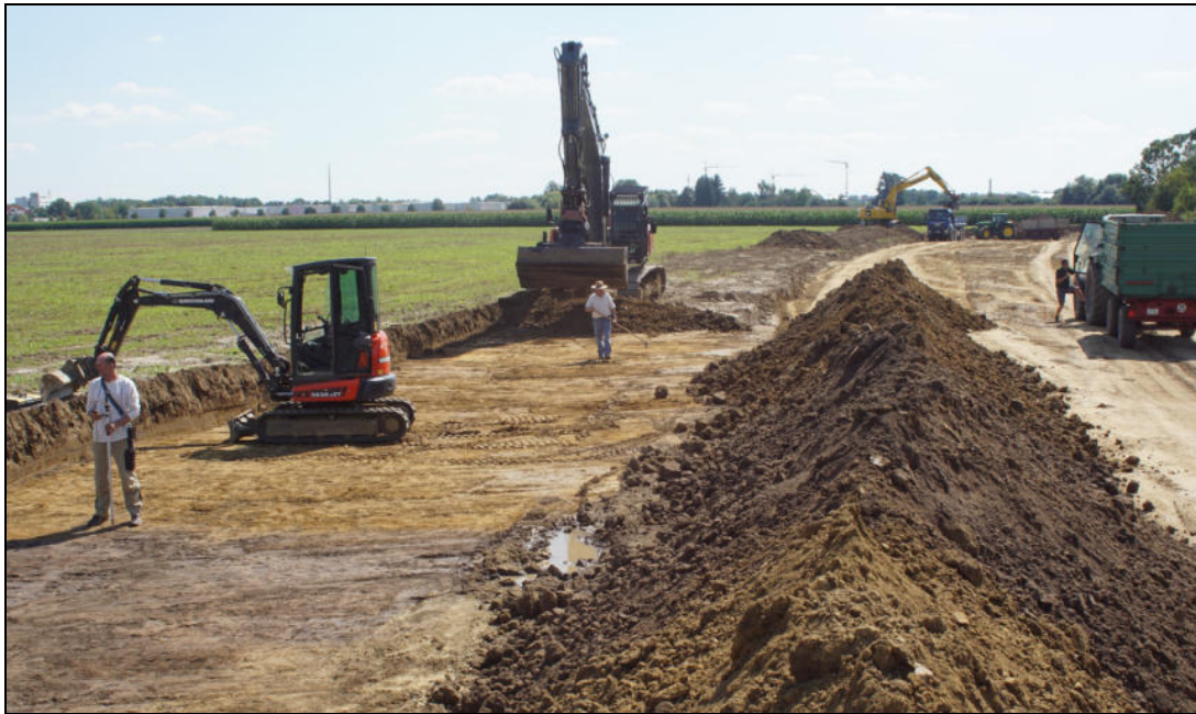
Abb. 4 Oberbodenabtrag in der westlichen Erschließungsstraße.
