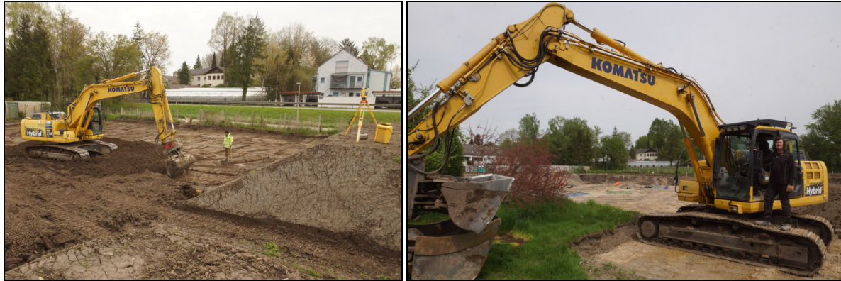
Abb. 1 Links: Abtrag der Humusdecke bis auf die Oberkante des Hangkolluviums im Bereich der Alzheimer Siedlung. Rechts: Herr Karoly Ruda von Fa. Fehlberger gegen Ende der Erdarbeiten.
