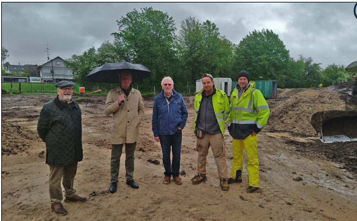
Abb. 7 Nicht aus Zucker. Baustellenbesuch bei widriger Witterung.
