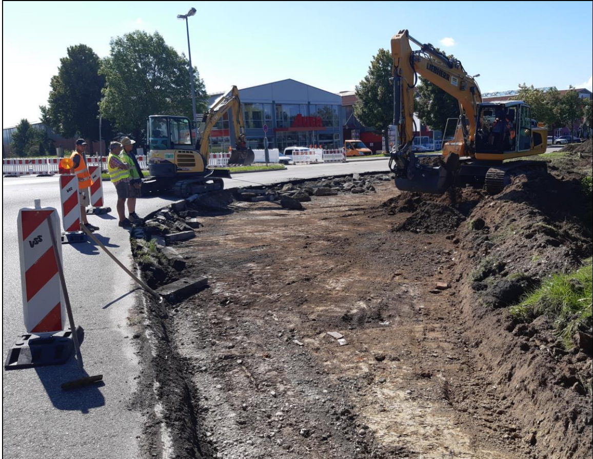
Abb. 16 Baggerarbeiten im Bereich der Fläche 4 mit viel rezentem Auffüllmaterial
