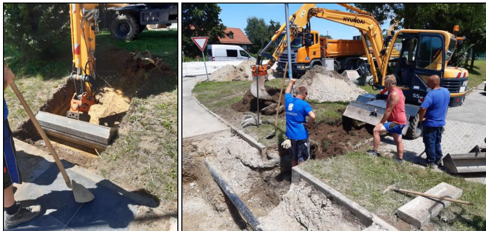
Abb. 3 Links: Anlage Schnitt 3. Rechts: Schachtarbeiten im SW von Fl. 2.
