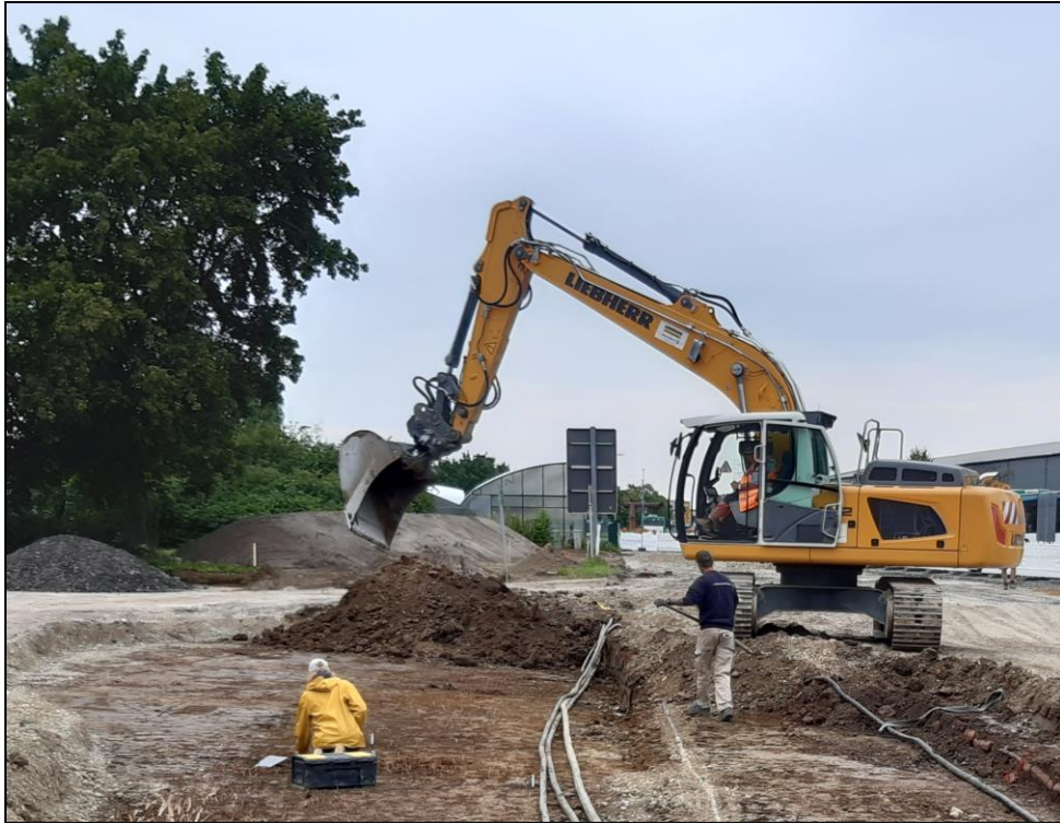
Abb. 2 Oberbodenabtrag im Bereich der Fläche 5 – nördlich der alten Dachauer Straße.
