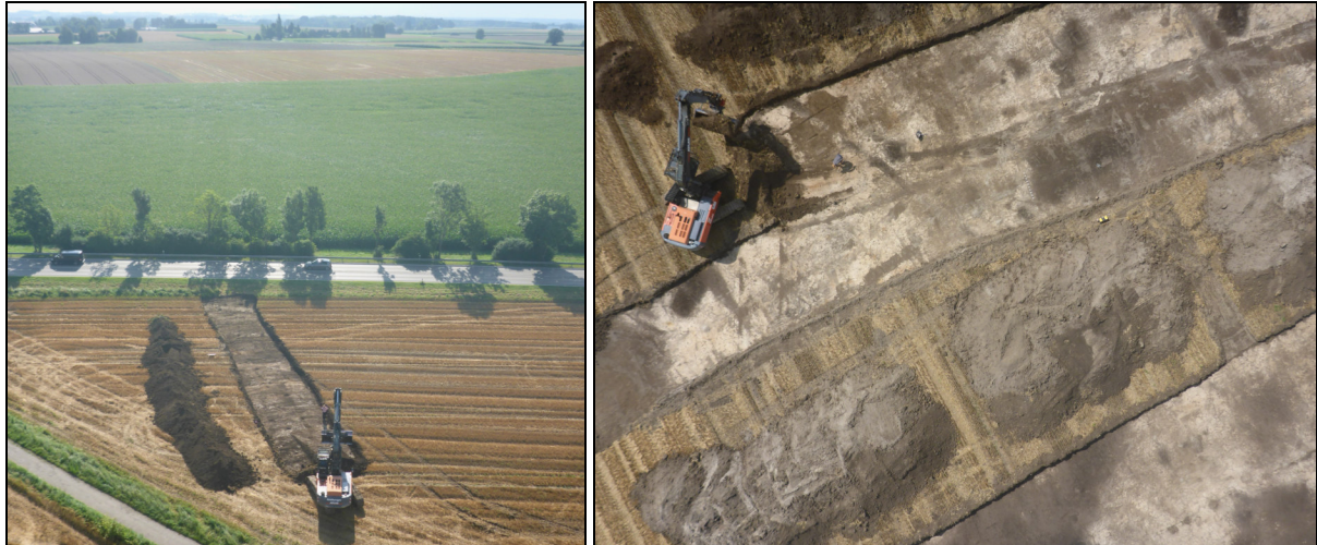
Abb. 1 Links: Beginn des Erdbaus am Nordrand der künftigen Retentionsfläche. Rechts: Gräben, Gräbchen und Geologien. Luftbilder mit dem Hebedrachen.
