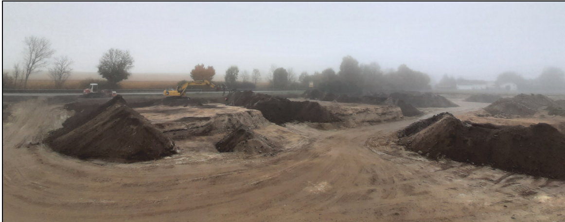
Abb. 1 Herbststimmung: Oberbodenabtrag der letzten Teilfläche im Bereich der Retentionsmaßnahme.
