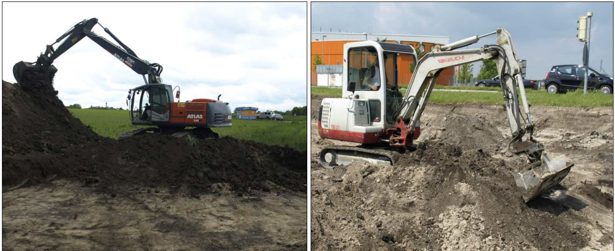
Abb. 7 Links: Kettenbagger beim Oberbodenabtrag. Rechts: Takeuchi Minibagger mit schwenkbarer Humusschaufel.
