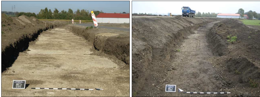
Abb. 5 Links: seitliche Lagerung des Humusmaterials. Rechts: Einbau in Teilfläche 3.
