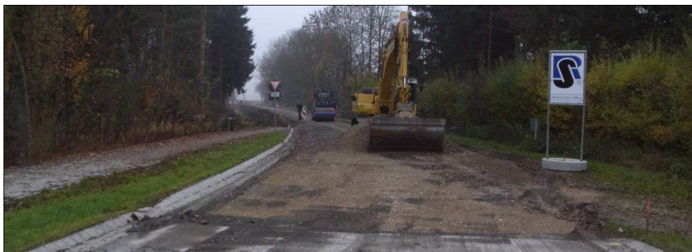
Abb. 7 Rückbau des alten Straßenkörpers durch Fa. Richard Schulz.
