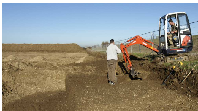
Abb. 7 Arbeiten an Brunnen Bef. 60 mit dem Minibagger.
