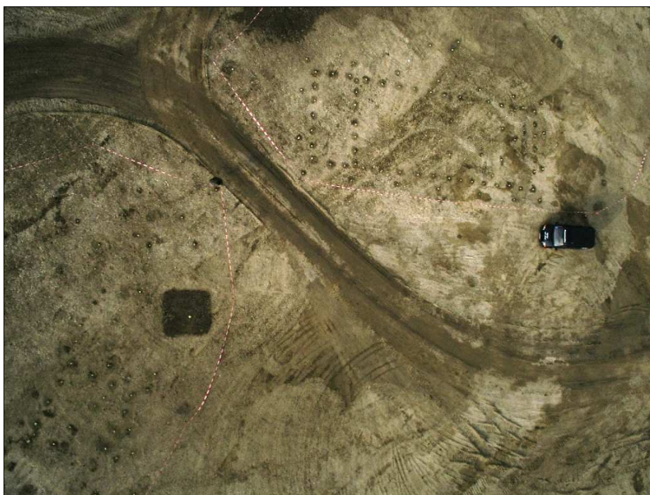
Abb. 2 Mit Trassierbändern gesicherte, befundführende Areale und freigegebene Baustraßen.
