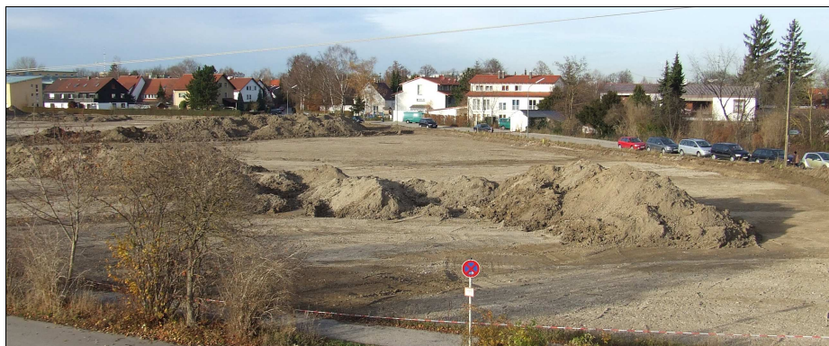
Abb. 8 Die Fläche kurz vor Beendigung des Oberbodenabtrages gegen NNW.
