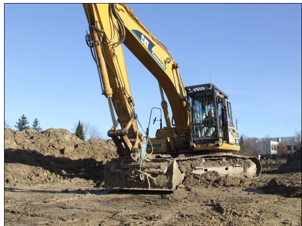
Abb. 1 Anlage der Humusmieten südlich der Grabungsfläche; Oberbodenabtrag mit dem CAT 325B-Kettenbagger.
