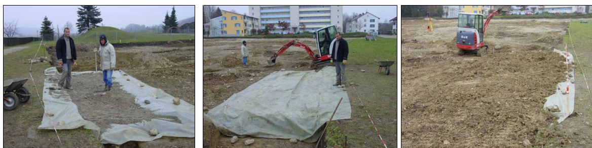
Abb. 40 Abdeckung von Haus 42 mit 1. Plane, Kies, 2. Plane und anstehendem Material.
