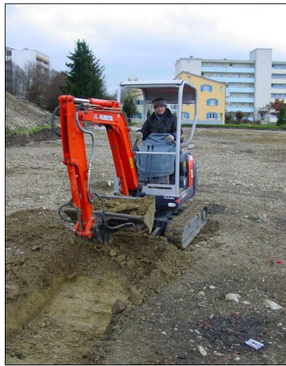
Abb. 9 Anlage einer Arbeitsgrube neben Befund 314.
