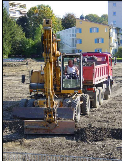
Abb. 7 Der Oberbodenabtrag mit Mobilbagger und LKW.
