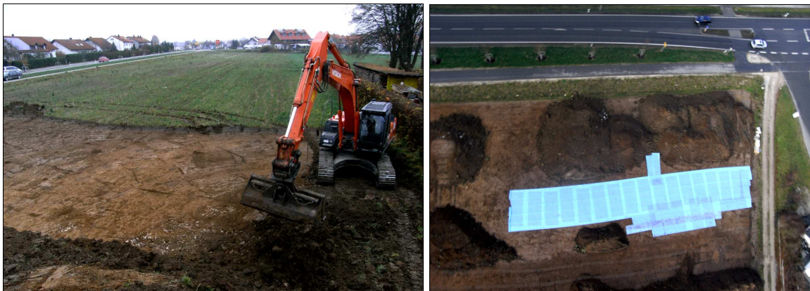
Abb. 2 Links: Übersicht über das Grundstück von WSW. Rechts: Ostteil nach Oberbodenabtrag mit teilweise abgeplanter Fläche (Luftbild mit dem Hebedrachen).
