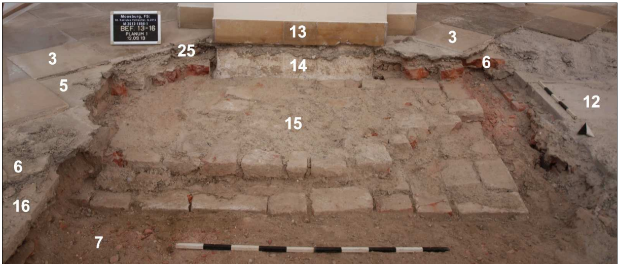
Abb. 11 Fundament des nördlichen Seitenaltars gegen Norden.
