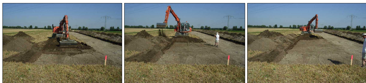
Abb. 2 Anlage des Baggerplanums (in GI 10).
